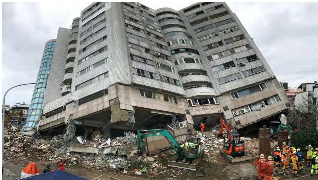
圖二 2018 2 月 6 日傍晚花蓮發生芮氏規模 6.2 級強震，造成雲門翠堤大樓嚴重傾斜。
