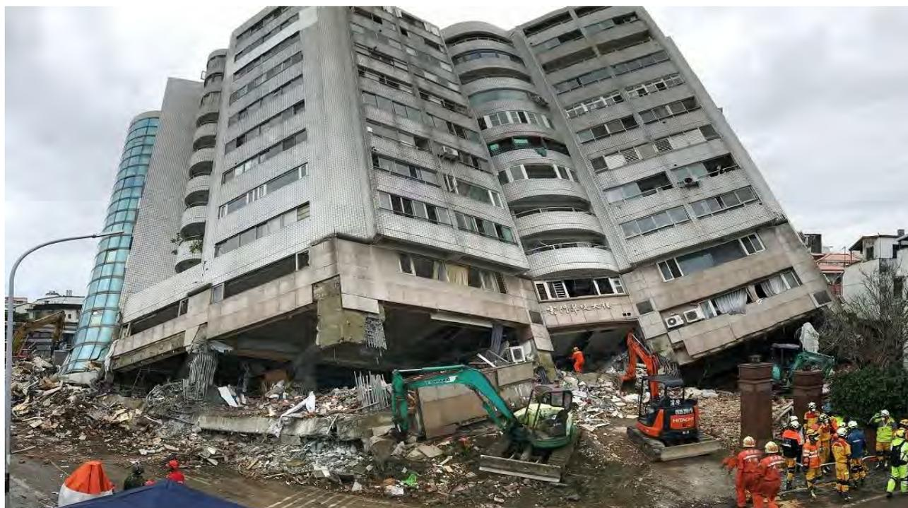
圖二 2018 2 月 6 日傍晚花蓮發生芮氏規模 6.2 級強震，造成雲門翠堤大樓嚴重傾斜。
